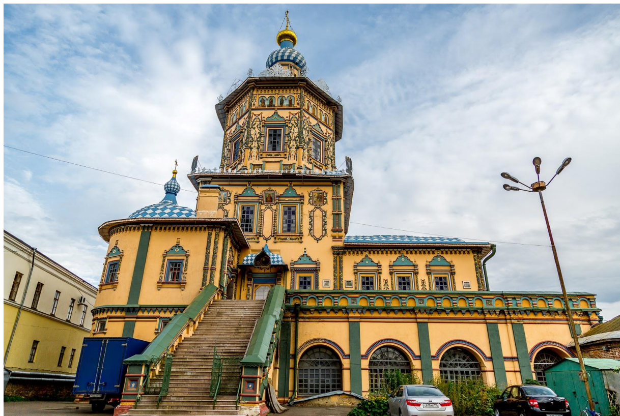
Фото 26. Петропавловский собор, вид с севера (Источник: tokzn.ru )
