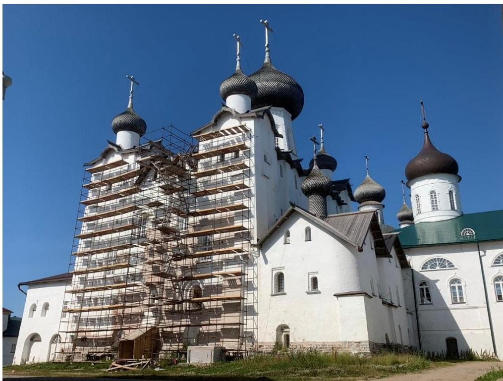
*Фото 8. Спасо-Преображенский собор – вид с юга. Собор построен новгородскими мастерами и напоминает крепость с 4 угловыми приделами-башнями, толщина стен достигает 5 метров.*
