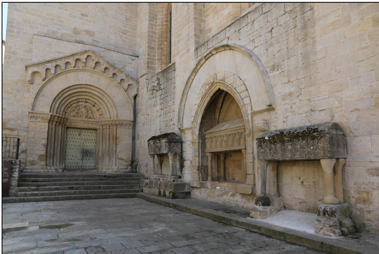
Фото 53. Входной портал церкви крупным планом.
