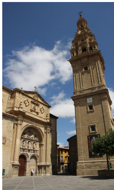
Фото 33. Собор и колокольня
